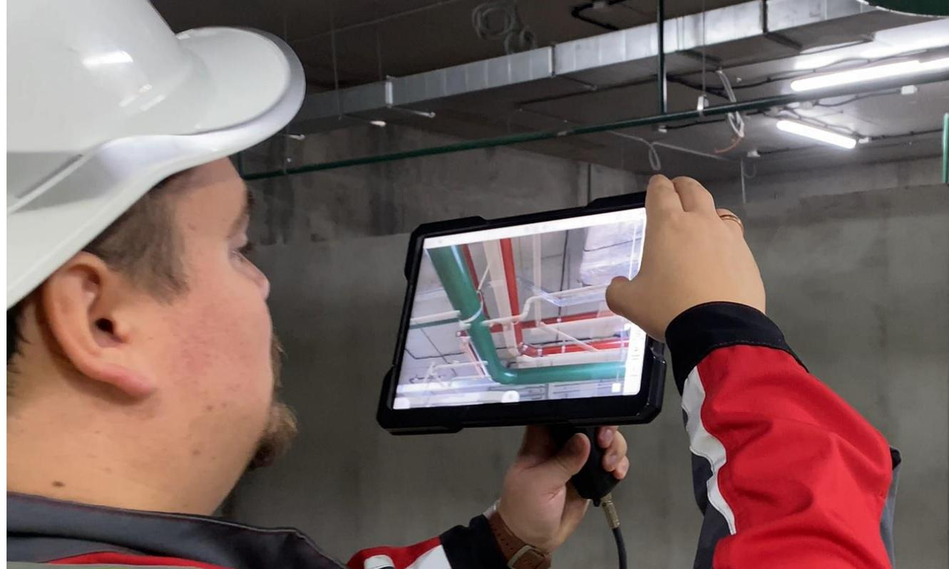
Искусственный интеллект (AI) и компьютерное зрение (CV) **встраивает информационную модель (BIM) в реальное окружение стройки**
